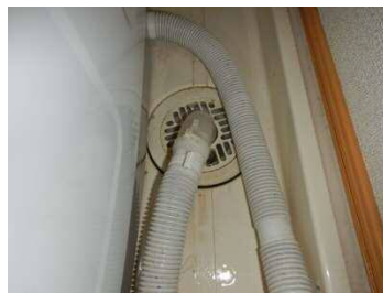
⑥排水トラップを戻し 完了です！
