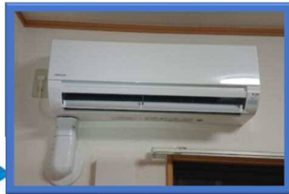
▲エアコン交換
